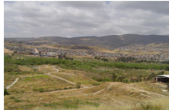
Tramo del acueducto que cruza el Río Alamar, Km. 11+432
