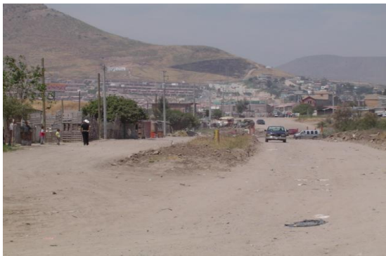
Tramo del acueducto en el cruce de la carretera antigua Tijuana-Tecate y Blvd. del Acueducto.
