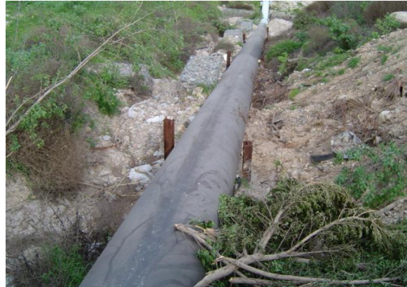
Tramo rehabilitado con tubería de acero y hierro dúctil de 48" de diámetro, calle Melchor Ocampo.
