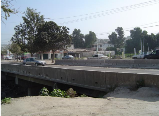
Tramo del acueducto que pasa por un costado del puente que esta a la altura de las colonias Los Reyes y Los Venados.
