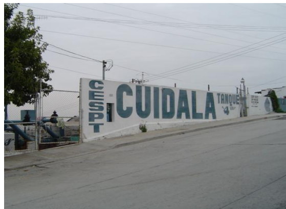
Frente del tanque 41/2, se construyó en 1968 en la elevación 208 msnm.
