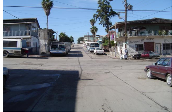
Tramo del acueducto que pasa por el cruce de las calles Abraham González y Miguel Guerrero, Col. Francisco. Villa, Km.0+386.59
