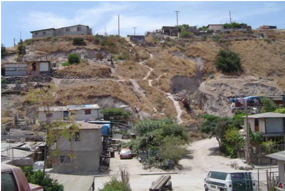
Tramo del acueducto afectado en la Colonia México Lindo, entre el Km 11+717.65 y 11+915.29
