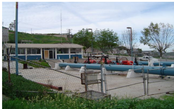
Punto de llegada del Acueducto en la Planta de Bombeo Obrera.
