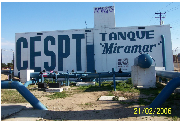
Llegada al Tanque Miramar ubicado en las calles 29 y prolongación de las Rosas, Col. Gran Tenochtitlan, capacidad 1,000 m 3 , elev. 200.9 msnm, Km. 3+724.72
