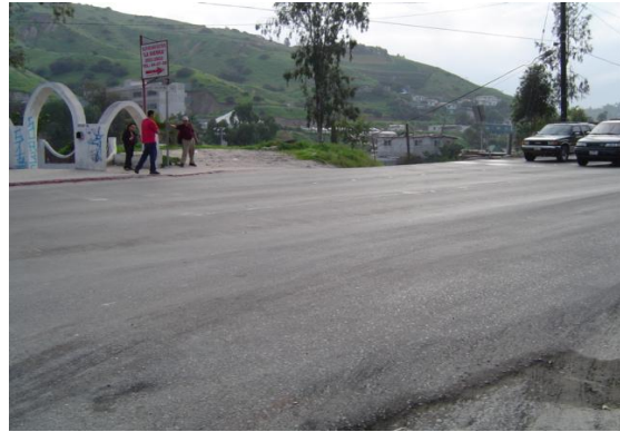
Tramo del acueducto en el cruce de la carretera libre Tijuana-Ensenada y calle Popocatepelt del Fracc. La Sierra, Km 2+005.87
