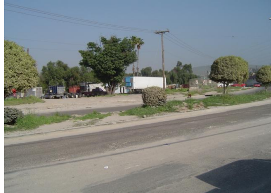
Tramo del acueducto que afecta predio del Fracc. García a la altura del acceso al Fracc. Lomas de la Presa.
