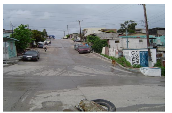
Tramo del acueducto que pasa por las calles Jorge Mistral y Lupe Vélez, Col. Gran Tenochtitlan, Km.4+144.17
