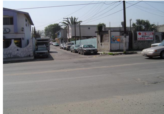
Tramo del acueducto en el cruce de la calle Plutarco Elías Calles (calle 11) y callejón Quintana Roo, Zona Este.
