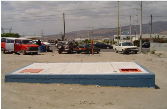
Derivación del acueducto en el cruce de las calles Acueducto y Rosa de Castilla, Col. Lomas de Matamoros, Km 8+947
