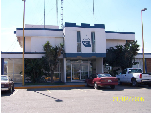
Inicia el acueducto en la Potabilizadora El Florido, elevación 244 msnm., con diámetro de 48", Km. 0+000.
