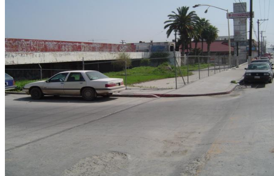
Tramo del acueducto reubicado por fuga en cruce de pluvial, entre Blvd. Agua Caliente y calle Barraquita (ex-tienda ISSSTE).
