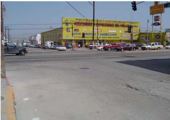
Cambio de dirección del acueducto, alimentación al Tanque Alba Roja, cruce Blvd. Gustavo Díaz Ordaz y calle Tacubaya.
