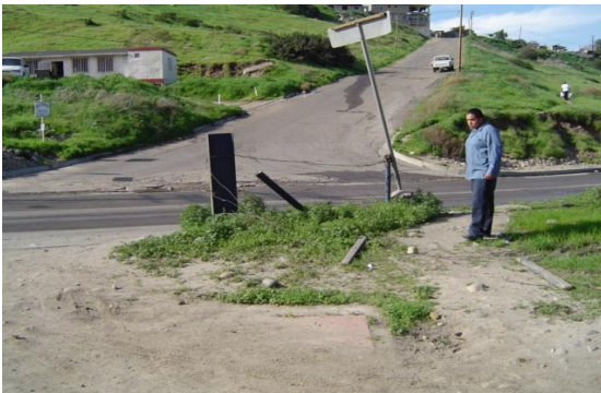
Tramo del acueducto que atraviesa el predio de Salubridad y Asistencia en el Blvd. Fundadores, Km 3+809.32
