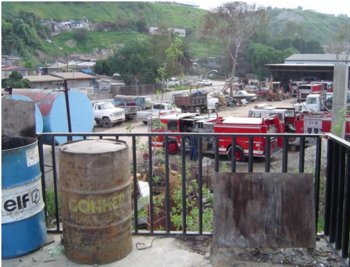
Cruce del acueducto por predio de taller mecánico, se ubica también el registro donde se deriva el acueducto Obrera-Playas.
