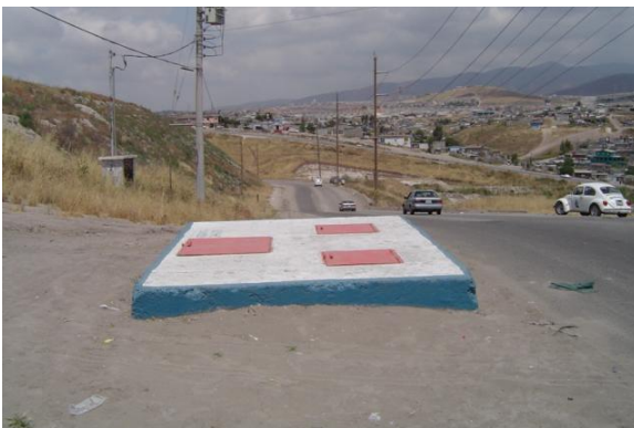
VAYEA del acueducto en cruce Ruta Amaranto y calle Grosella, Col. Florido 4ta. Sección, Km 2+601
