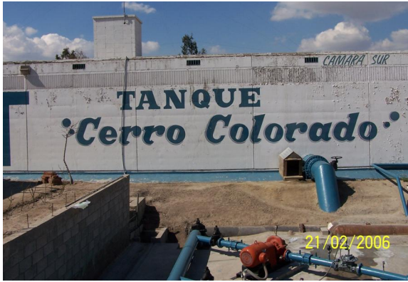
Conexión con el Tanque Cerro Colorado, capacidad de 20,000 m 3 , Km 7+150
