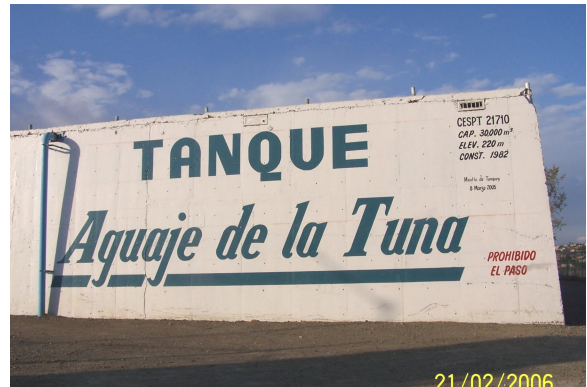
Termina el acueducto en el Tanque Aguaje de la Tuna, con capacidad de 30,000 m 3 , elevación 218 msnm, Col. Aguaje de la Tuna.
