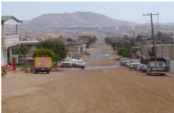
Tramo del acueducto que pasa en la calle Mazatlán de la Col. Las Torres.
