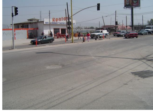
Tramo del acueducto que se modificó por construcción de pluvial, cruceo Blvd. Gustavo Díaz Ordaz y calle México Lindo, Delegación Los Pinos.
