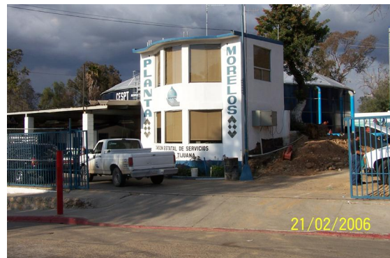
Termina acueducto en la Planta Morelos, elevación 59 msnm, capacidad 5,000 m 3 .
