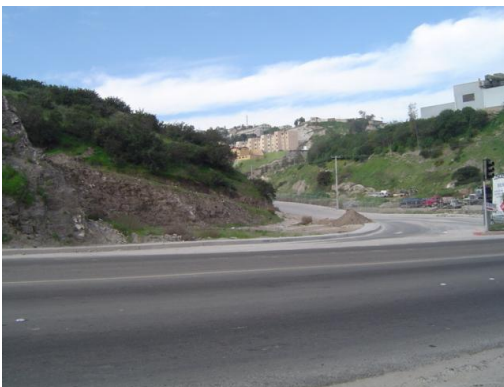
Cruce del acueducto en la carretera libre Tijuana-Ensenada con tubería de 42" de diámetro.
