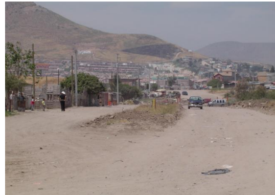
Tramo del acueducto en el cruce con carretera antigua Tijuana-Tecate y Blvd. del Acueducto.
