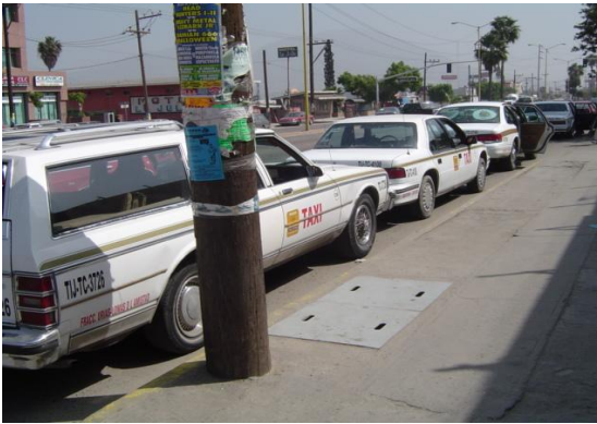
Tramo del acueducto a la altura de la calle Fresno (32 Sur), Delegación Los Pinos.
