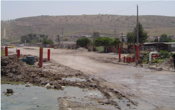
Desfogue del acueducto en el cruce con arroyo, Col. La Morita, Km. 1+070
