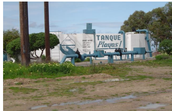
Termina acueducto en el Tanque Playas I, ubicado dentro del Parque Industrial Tecnomex, capacidad 2,700 m 3 , elev. 118.76 msnm, Km 8+673.41
