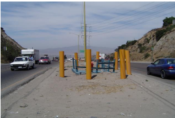
VAYEA del acueducto que pasa por el Libramiento Oriente, Km. 18+022.57
