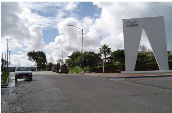
Tramo del acueducto en el cruce de la avenida Rodolfo Sánchez T. y entrada al Parque Industrial Tecnomex, Km 8+027.28
