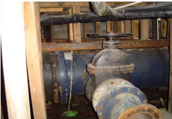
Cambio de dirección del acueducto en el Cruce del Blvd. Gustavo Díaz Ordaz y calle Quinta Alta.
