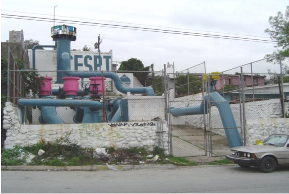
Inicia en la torre controladora de gasto del tanque 41/2, Col. Francisco Villa.
