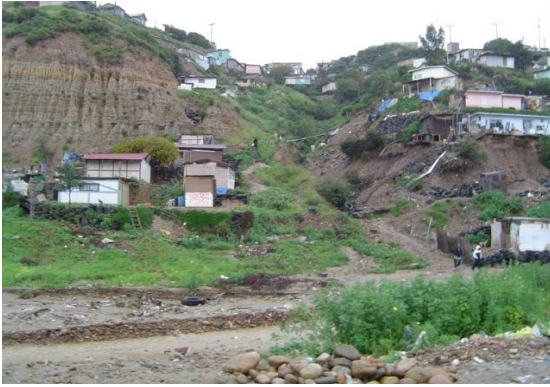
Tramo del acueducto en el cruce con el arroyo de la col. Rancho las Flores, Km 4+700
