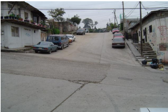
Tramo del acueducto que pasa por las calles Justo Sierra y Matías Gómez de la Col. Francisco Villa, Km 5+491.29
