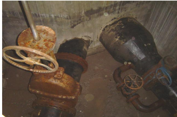
Interior del registro donde deriva al Obrera-Playas y Planta Obrera.
