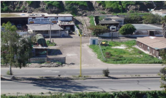
Tramo del acueducto en el cruce del libramiento Rosas Magallón, Km 1+340.57
