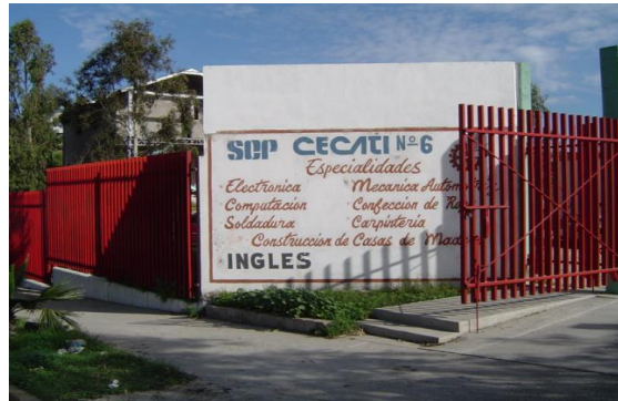
Tramo del acueducto que atraviesa al CECATI No.6 de la Col. Rubí Km 3+250.00
