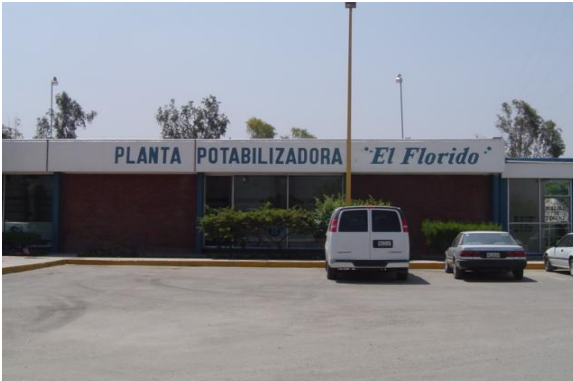
Inicia en la Potabilizadora El Florido, elevación 244 msnm, con diámetro de 48”.
