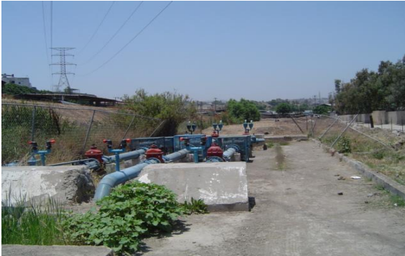
Rompedora de presión la Marimba, en el Fraccionamiento García, Km. 9+000
