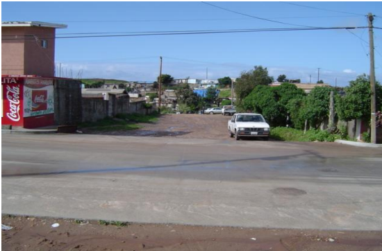
Crucero donde el acueducto deriva hacia el Tanque Lázaro Cárdenas I, calles Nicolás Bravo y Emiliano Zapata, Km 6+189.47
