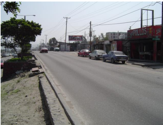
VAYEA del acueducto en el cruceo Blvd. Gustavo Díaz Ordaz y calle Emiliano Zapata, Delegación Los Pinos.
