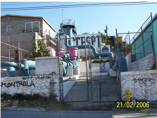
Termina acueducto Primera Etapa en Tanque 41/2, capacidad de 1,000 m 3 , Km 6+123.70
