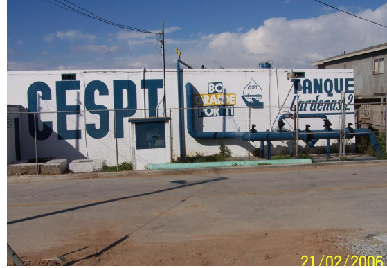
Llegada al Tanque Lázaro Cárdenas II, ubicado en la calle Vicente Suárez de la Col. Lázaro Cárdenas, capacidad de 1,000 m 3 , elevación 191.7 msnm, Km 5+698.53
