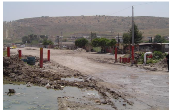
Desfogue del acueducto, cruce por un arroyo en el Blvd. del Acueducto, Col La Morita, Km.1+147.25
