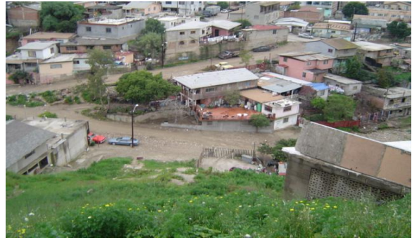
Tramo del acueducto que atraviesa predio del Km 5+151.64 al Km 5+302.79 de la Col. Francisco Villa.
