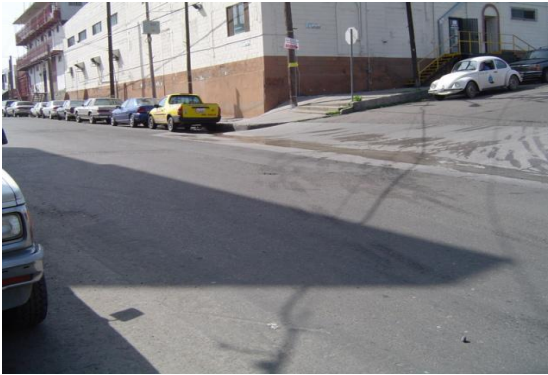
Tramo del acueducto en el cruce de las calles Serra (calle 12) y Camino Nuevo, Zona Este.
