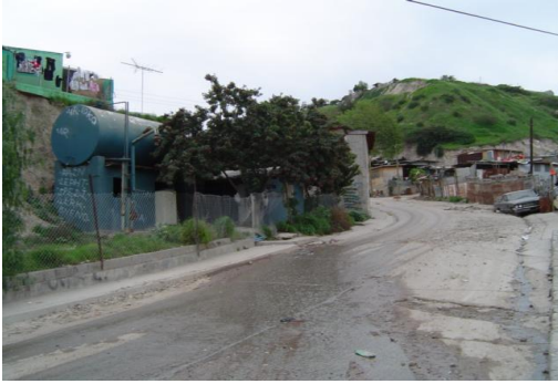
Tramo del acueducto que cruza predio en la calle Plutón, Col. Planetario.
