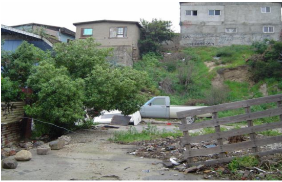
Tramo del acueducto que es afectado del Km 4+622.85 al Km 4+692.02 de la Col. Monte San Antonio.
