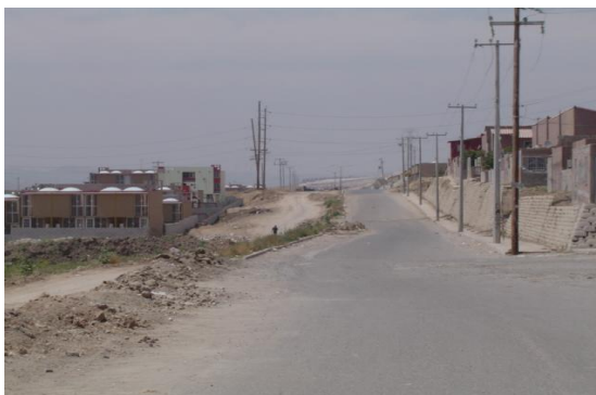
Tramo del acueducto que pasa por el Blvd. Las Fuentes del Fracc. Hacienda Las Fuentes.
