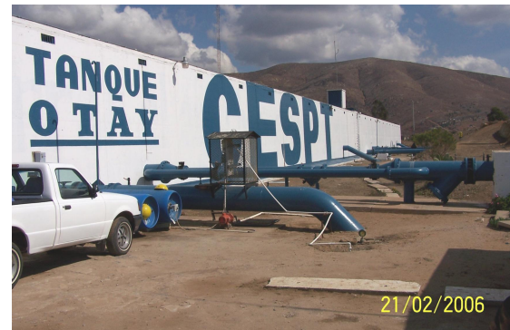
Termina el acueducto en el Tanque Otay, capacidad de 20,000 m 3 , elevación 191 msnm, Km.13+629
