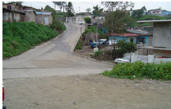
Tramo del acueducto que pasa por el cruce calle Matías Gómez y Cañón Progreso, de la Col. Progreso, Km 5+555.41
