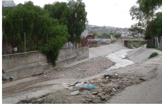
Cruce del acueducto por canal pluvial, Col. Planetario.
